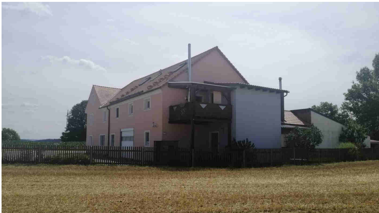
Foto vom Ortstermin, nördlich liegende relevante Bebauung
